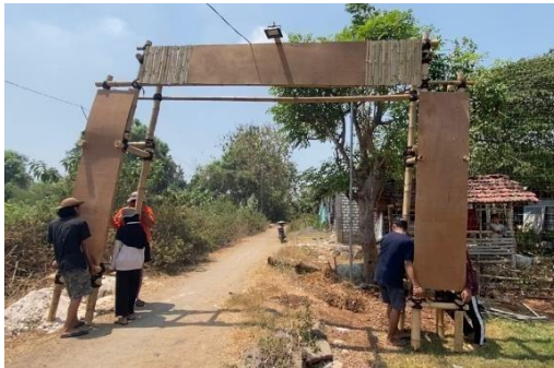
Gambar 14. Proses Mendirikan Gapura
