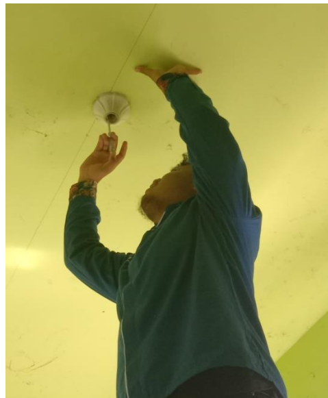
Gambar 5 : Perbaikan instalasi PONKESDES
