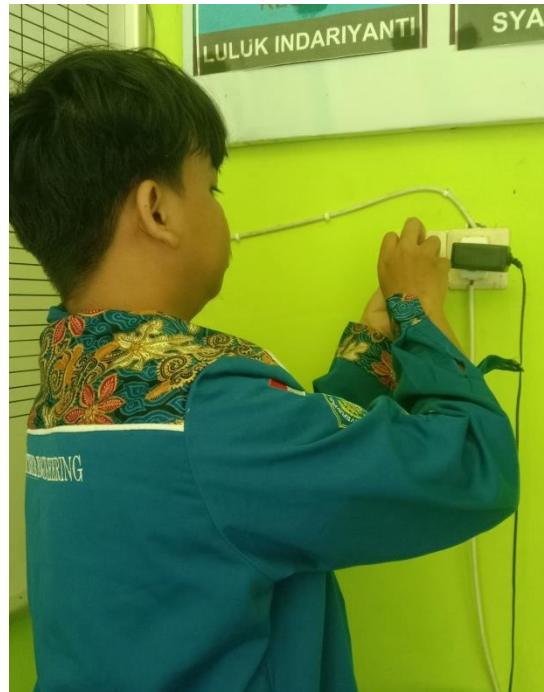
Gambar 6: perbaikan instalasi PONKESDES
