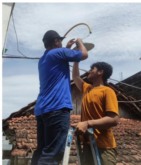
Gambar 7 : pemasangan instalasi penerangan jalan
