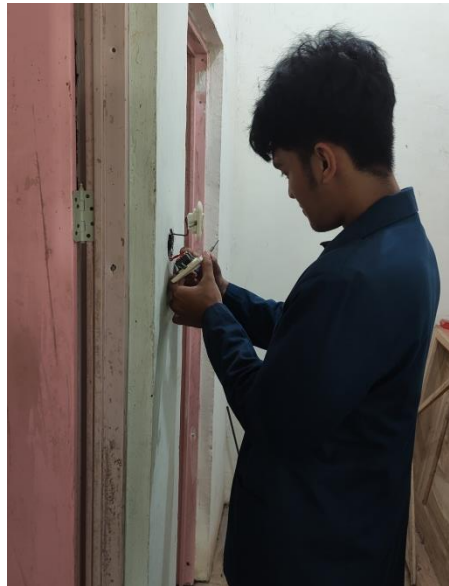
Gambar 4 : Perbaikan instalasi PAUD
