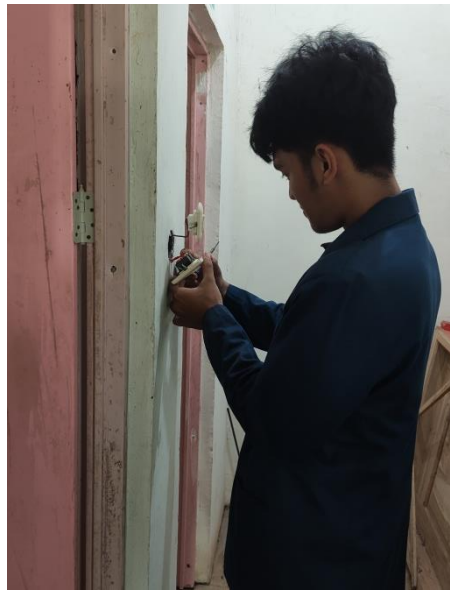
Gambar 4 : Perbaikan instalasi PAUD
