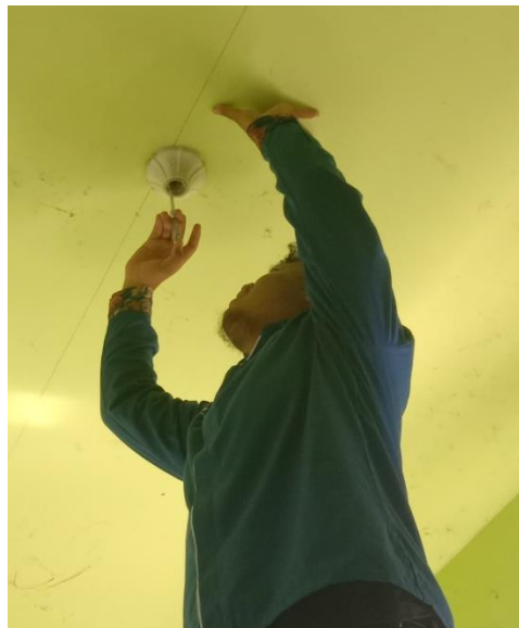
Gambar 5 : Perbaikan instalasi PONKESDES
