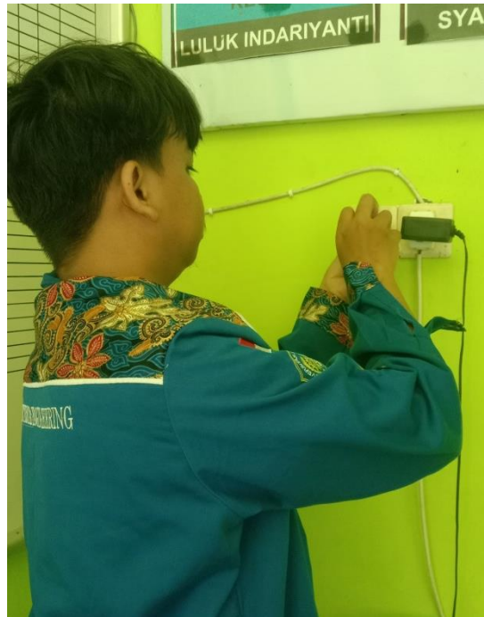
Gambar 6: perbaikan instalasi POKESDES
