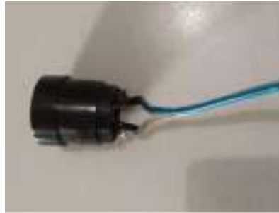
Gambar 3. Pemasangan kabel fasa dan netral ke fitting lampu
