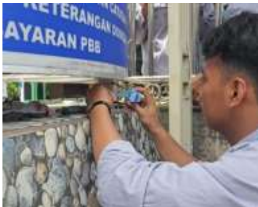
Gambar 7. Pemasangan Sensor Photocell
