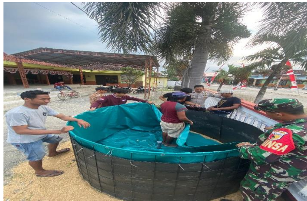
Gambar 3.1 proses pemasangan terpal bagian dalam kolam bersama babinsa dan warga
