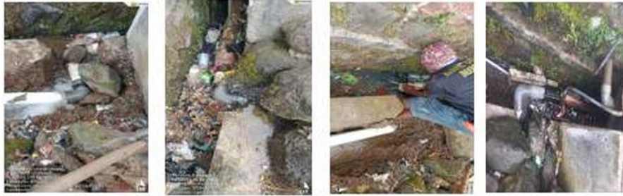
Gambar 1. Dokumentasi Perbaikan Kebocoran Jaringan Pipa di Wilayah Pelayanan Cabang Cibadak
