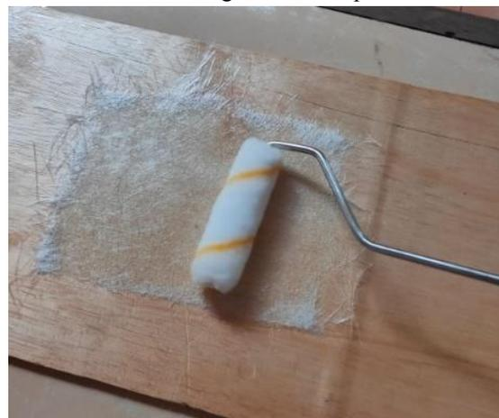
**Gambar 4.** Resin diratakan menggunakan roll
