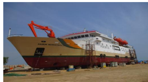
Gambar 1.1 Pembangunan KM. Sabuk Nusantara 78 di PT. Orela Shipyard
