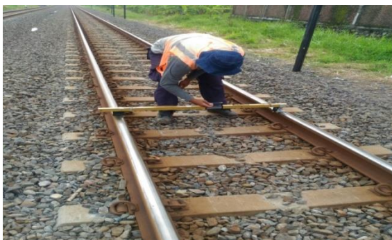
Gambar 1 proses pengecekan struktur jalan rel
