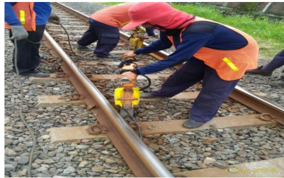
Gambar 2 proses pekerjaan menggunakan alat mekanis
