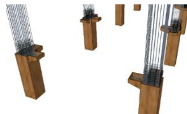
Gambar 3.7 Pemasangan Bekisting Kolom dan konsol
