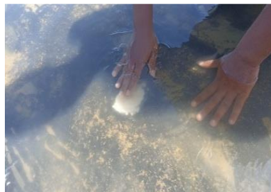
Gambar 2. Penambalan plastik HDPE Sumber: Data Primer (2025)
