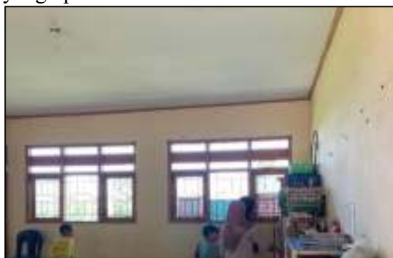
Gambar 2. Jendela dan ventilasi ruang kelas kelompok A
