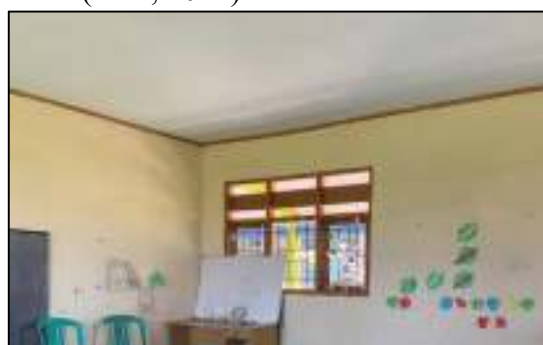
Gambar 3. Dinding ruang kelas kelompok A
