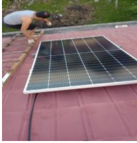
Gambar 1. Pemasangan Solar Panel
