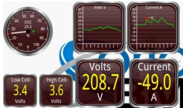
Gambar 2. Tampilan sistem SCADA pada BMS
