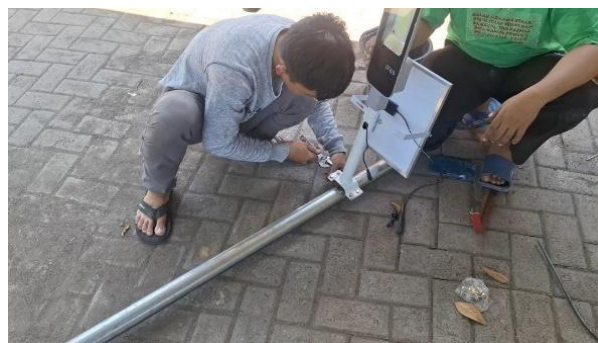
Gambar 2. Perakitan lampu penerangan jalan tenaga surya
