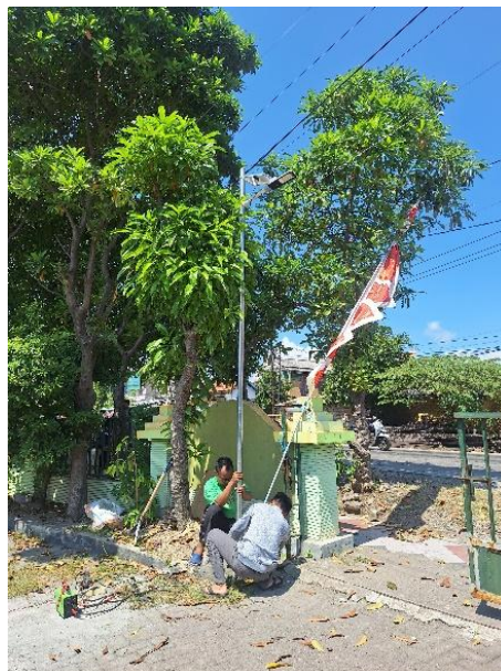
Gambar 3. Pemasangan titik penerangan di Kantor Kelurahan Kroman
