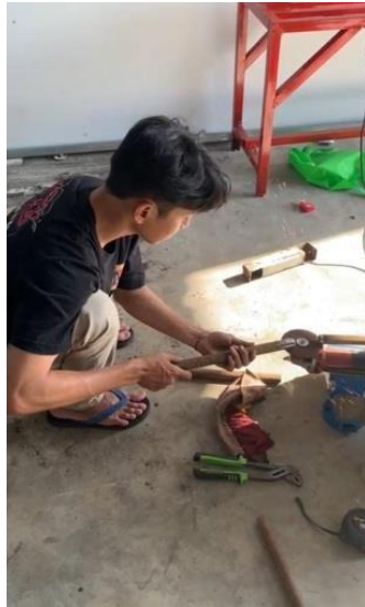
Gambar 2. Proses penyambungan besi.
