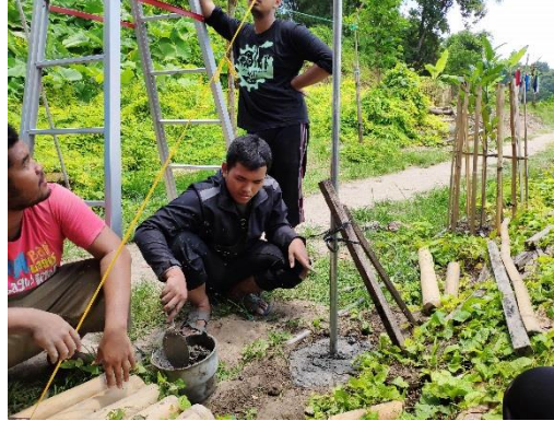
Gambar 5. Proses Pengecoran pondasi
