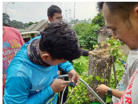
Gambar 4. Proses Pemasangan kabel pada joint klem
