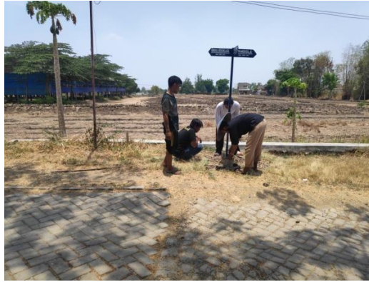
Gambar 3. Pemasangan papan/pelakat arah jalan
