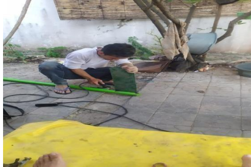
Gambar 1. Pembuatan frame papan/petunjuk arah jalan
